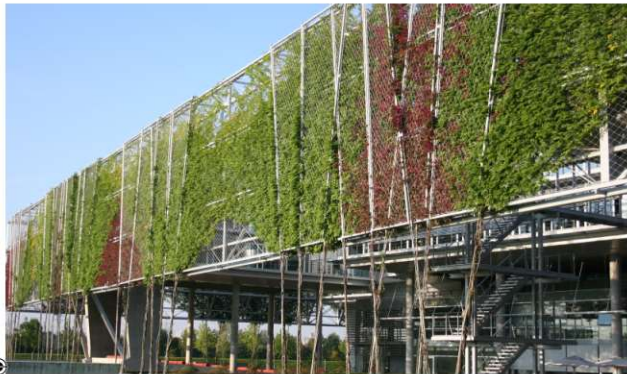
Schwebende Hecke, Gebäude Swiss Re München.
